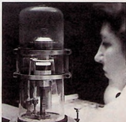
Hochfrequenz-Anglasung der Bildwandler-Kolbenteile
